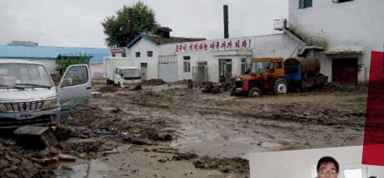
Détruite par les inondations La boulangerie dans un état catastrophique
